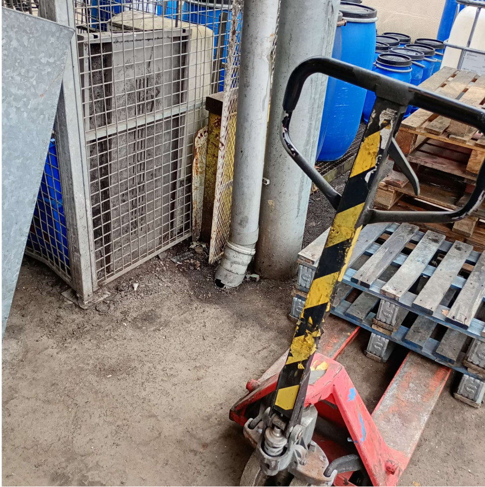
Descente dégradée d'eaux pluviales
