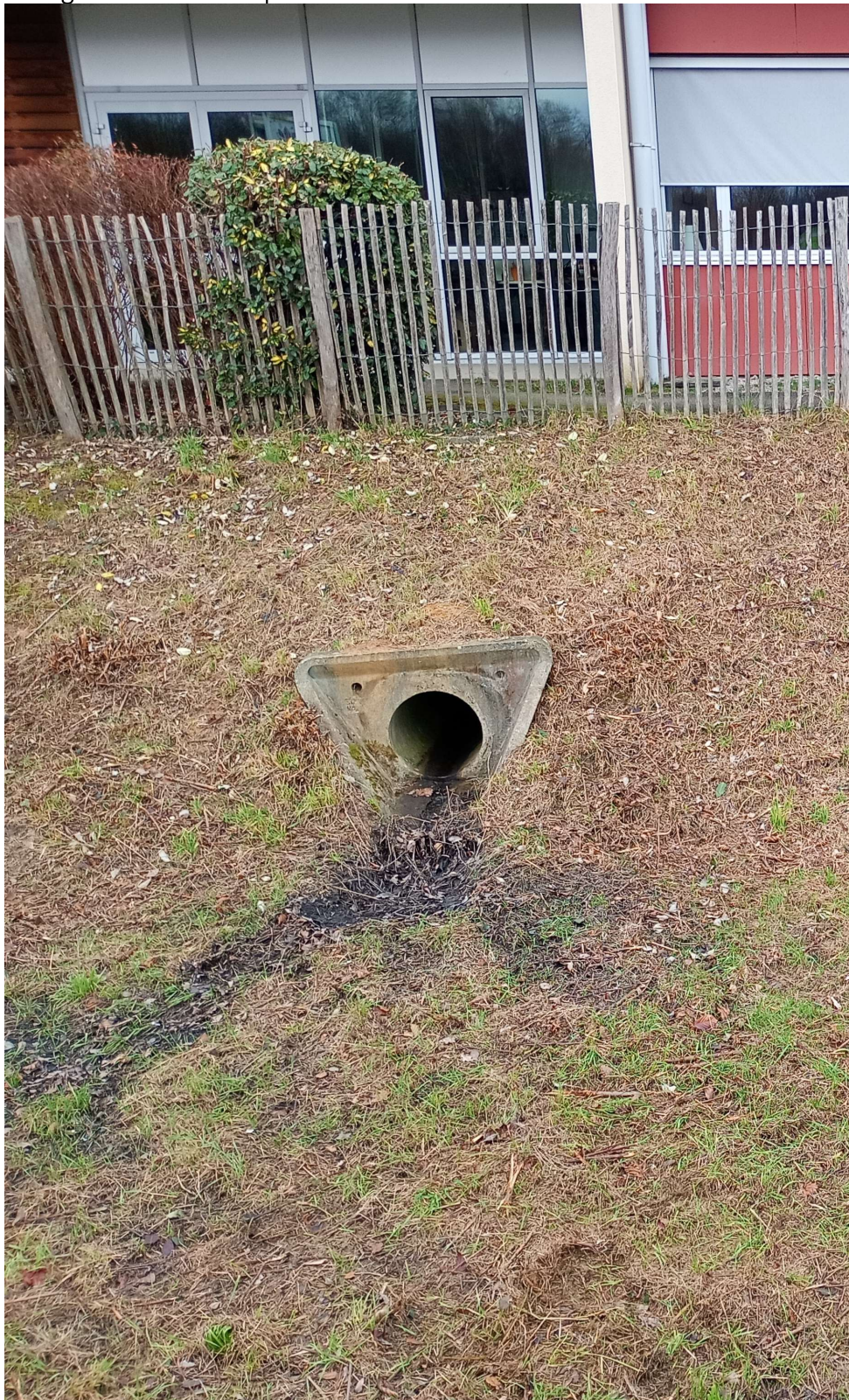
Arrivée dans le bassin de rétention, des eaux de ruissellement susceptibles d'être souillées, des eaux industrielles et eaux pluviales des toitures
